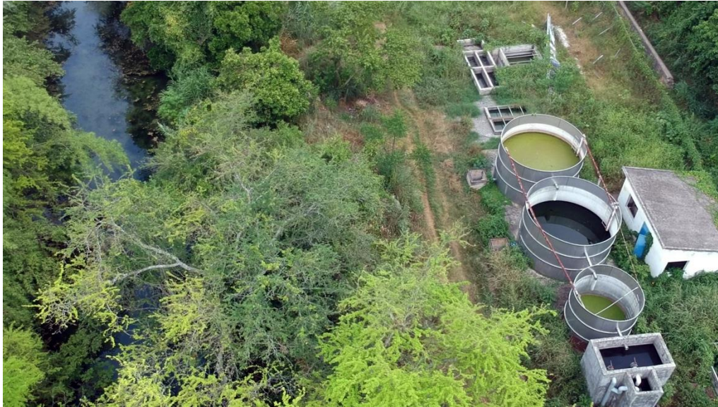
Figura 4. La PTAR a escasos metros del cauce del río Venado
